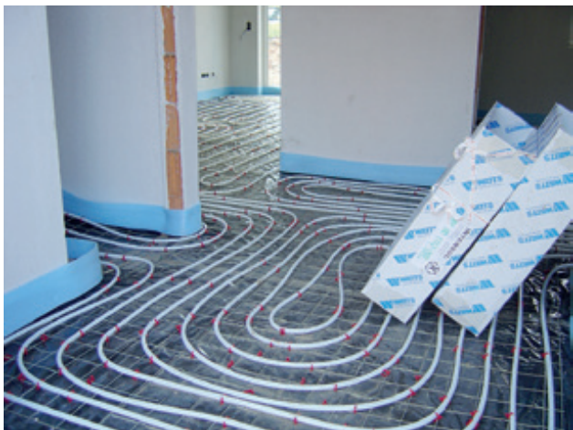
Abbildung 48 Beispiel Fußbodenheizung. Quelle: RMA.
