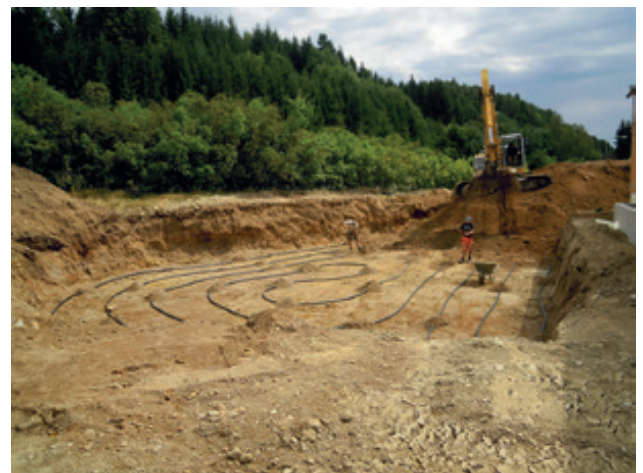
Abbildung 19 Boden als „Wärmequelle“ - Verlegung der Soleleitungen für eine Erd-Wärmepumpe. Quelle: Fam. Lepuschitz.
