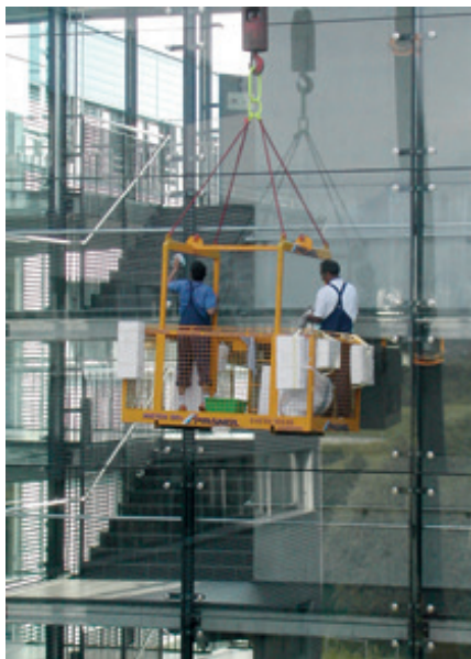
Abbildung 41 Reinigung einer Glasfassade. Quelle: RMA.
