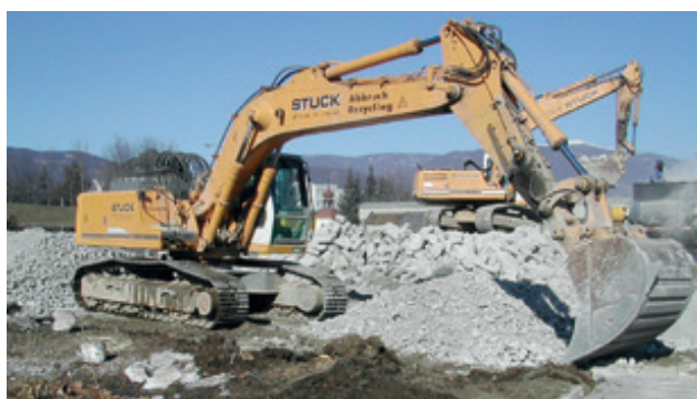
Abbildung 09 Aktivitäten auf der Baustelle. Quelle: RMA.
