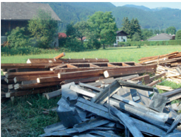
Abbildung 51 Getrennte Abfallsammlung auf der Baustelle. Quelle: RMA.
